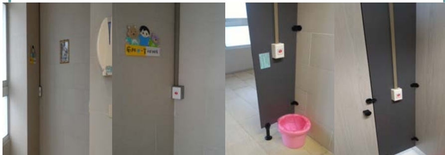
緊急按鈕設置於廁所出入口及各間女廁中
